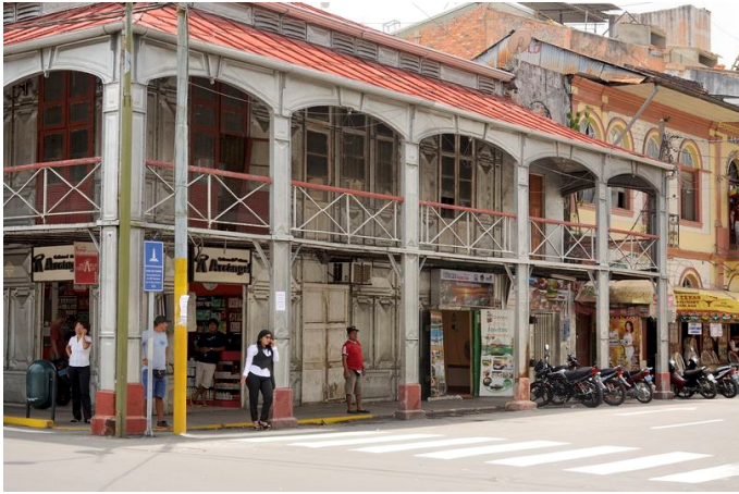
Ryc. 7. Casa de Fierro (dom ze stali) przy Plaza de Armas w Iquitos (Peru) zbudowany w 1890 r. według projektu G. Eiffła Źródło: fot. A. Czerny
