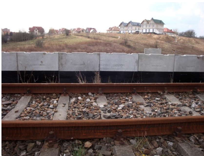
Fot. 4. W trakcie budowy peronu na nowym przystanku Lublin Ponikwoda, zlokalizowanym w sąsiedztwie powstającej zabudowy mieszkaniowej (20.04.2012, fot. Karol Kowalczyk)
